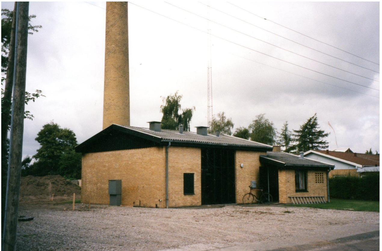
Fjernvarmeværket fra før ombygningen 1996
