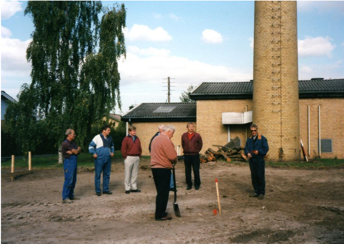
Borgmester Knud Knudsen tager første spadestik til kraftvarmeværket
