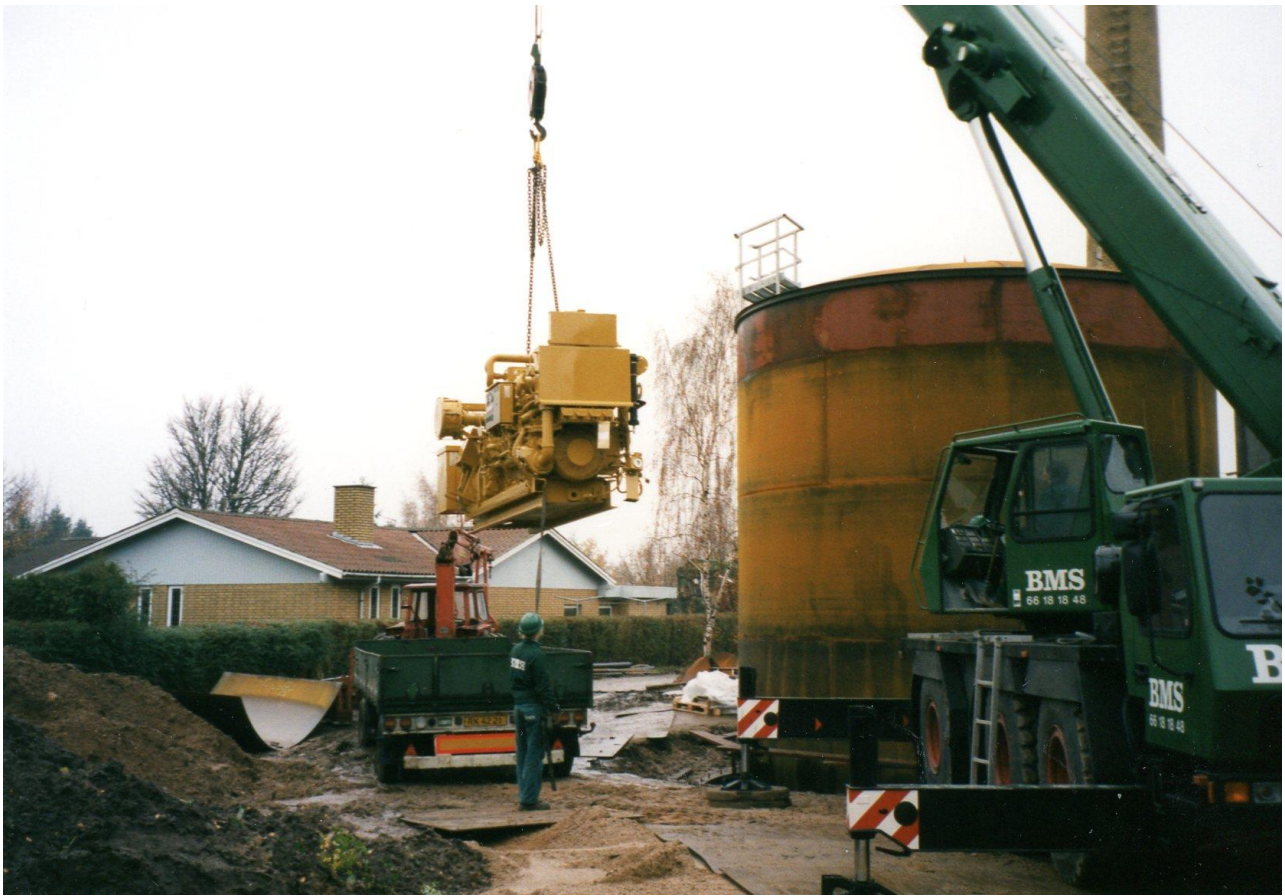
Den nye gasmotor løftes på plads
